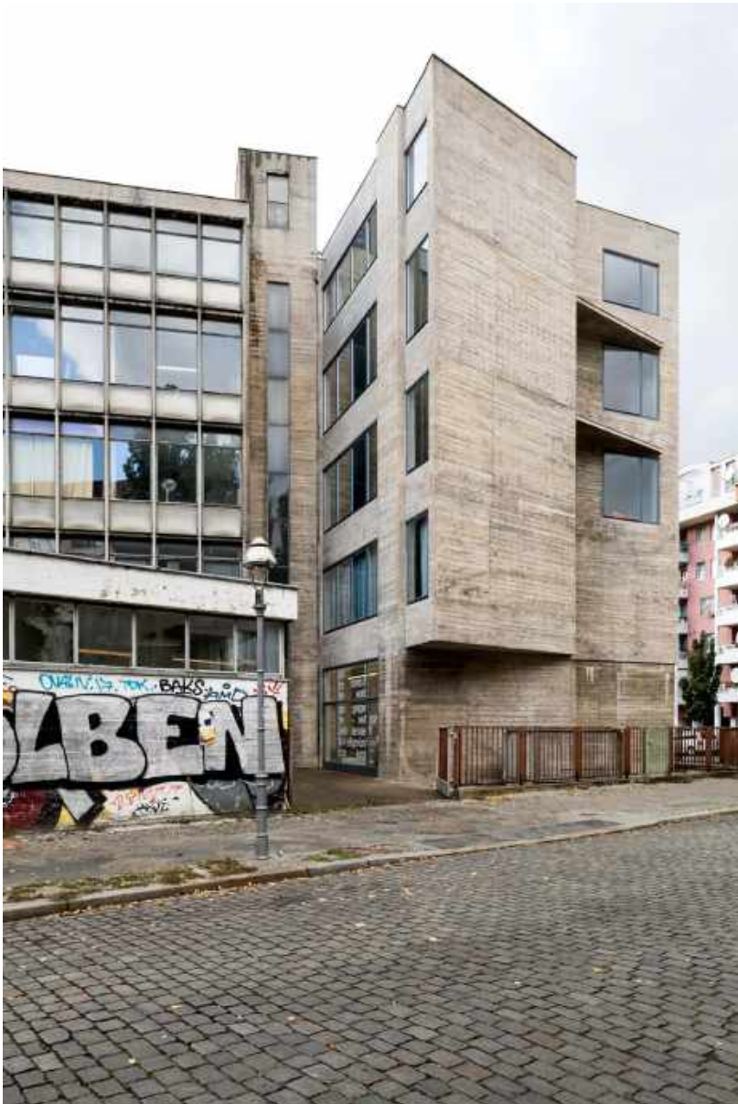
View corner tower, ExRotaprint (Gottschedstraße/Bornemannstraße)
